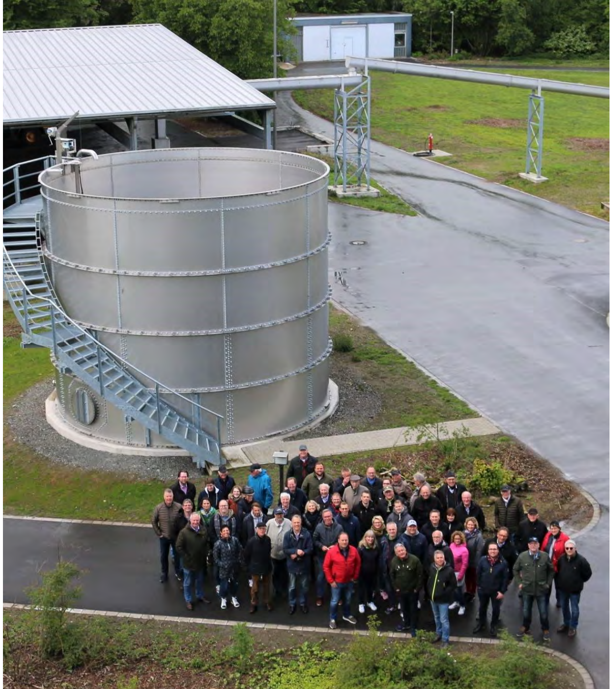
Gruppenbild an der Städtischen Kläranlage
